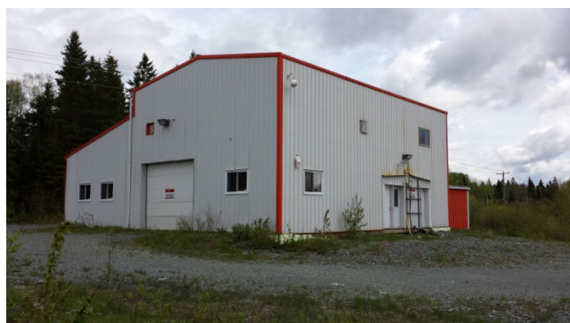
Einrichtung zur Vermessung von Bohrkernen
