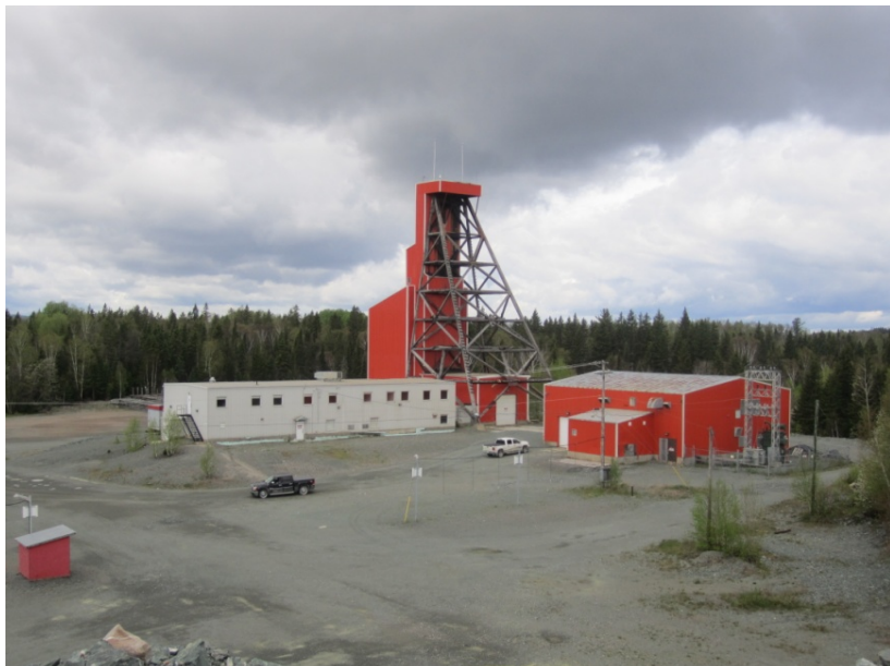
Bürogebäude, Förderturm Nr. 7 und Gebäude mit Förderanlage
