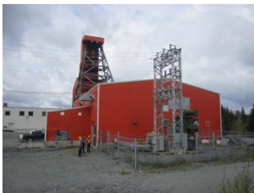
Gebäude mit Förderanlage, Förderturm Nr. 7 und Umspannanlage
